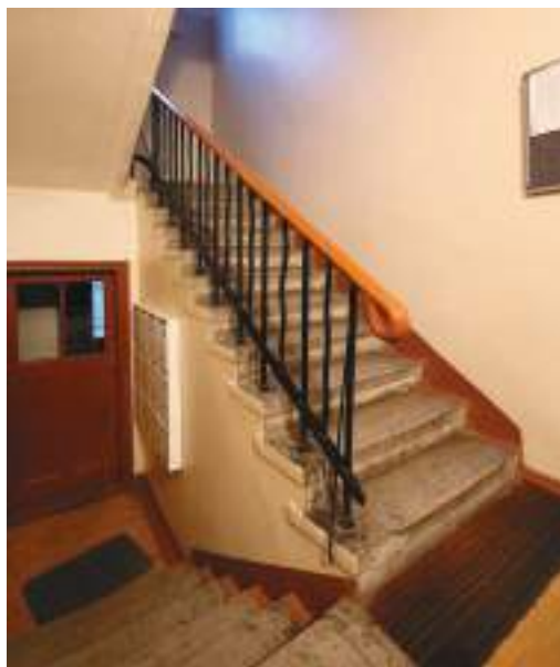
60. Uhkemate majade trepid on paekivist astmetega.
