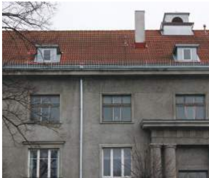
41. Teadlaste maja sademeveesüsteem. Kivikatuse räästapealne on vormistatud valtsplekiga, et oleks võimalik teha vastupidavam, katusepealne vihmaveeren. Vihmaveetoru on viidud läbi karniisi nagu algses projektiski.
