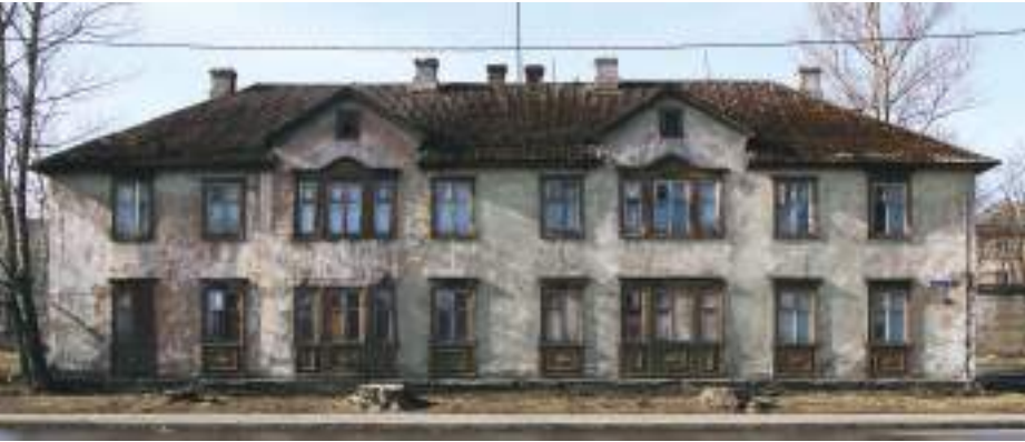
6. Vasara 14 Koplis. Sõjaväebarakiks ehitatud klassitsistlike detailidega kaunistatud krohvitud puitsõrestikmaja.
