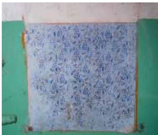
61. Hilisemate viimistluskihtide alt on välja koorunud trepikoja algne värvilahendus – 1950. aastate algusele omane rulliga tõmmatud maaling viinamarjamotiividega.
