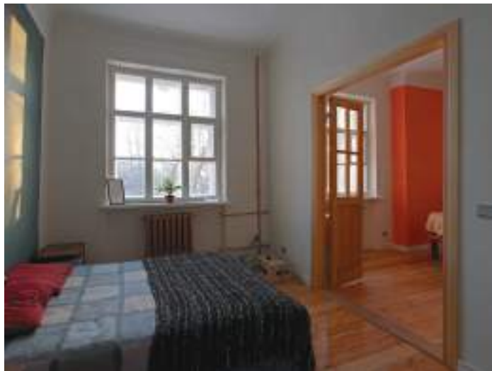
68. Aknad, siseuksed, laudpõrandad ja stukkornamendid on värvikihtidest puhastatud ja uuesti viimistletud.
