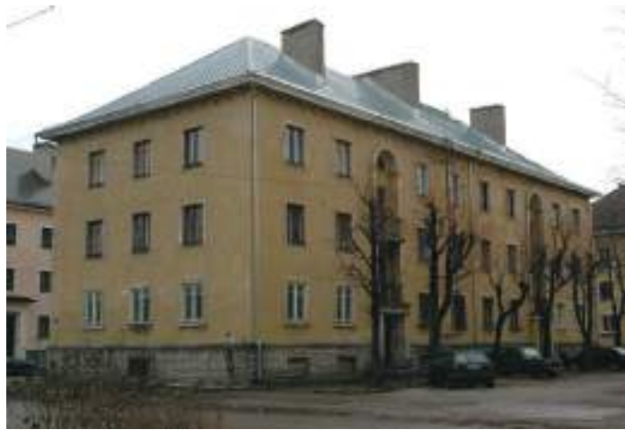
40. Järve 48. Korstnamaastik. Iseloomulik lõõride ühendamine laiaks korstnaks, mis võib ulatuda mõlemale poole katuseharja. Arhitekt Dmitri Mejerson, 1954.
