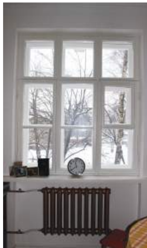
52. Kotzebue 5 restaureeritud aken. Vanad aknad ilmestavad nii fassaadi kui ka interjöörü.
