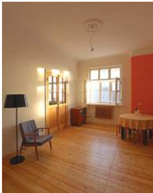
68. Aknad, siseuksed, laudpõrandad ja stukkornamendid on värvikihtidest puhastatud ja uuesti viimistletud.
