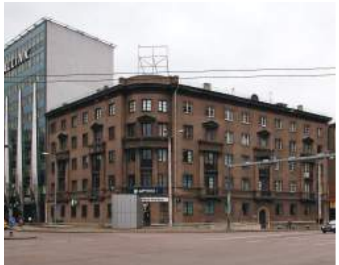
42. Gonsiori 3. Terrasiitkrohviga maja. Arhitekt P. Koido.
