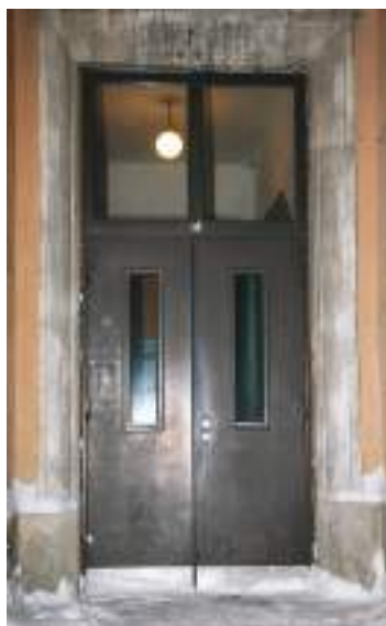
56. Koidu 75 sobimatu metalluks on asendatud algse ukse koopiaga.
