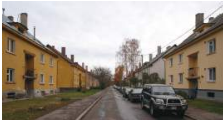
8. Nisu tänav Pelgulinna. Esimese kohaliku tüüpprojekti järgi ehitatud ühe trepikojaga kahekorruselised elamud. Lihtsat krohvitud fassaadi ilmestab metallpiirdega rõdu. Arhitekt Karl Tarvas.
