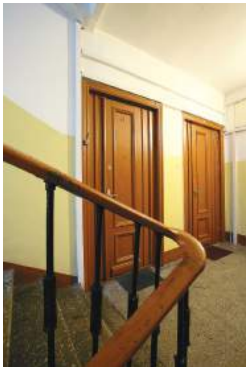
58. Trepikoda. Korteriuuste kvaliteet võis olla erinev: on väga uhkeid, väärispuidust vineeriga kaetud uksi, leidub ka tagasihoidlikke tahveluksi.
