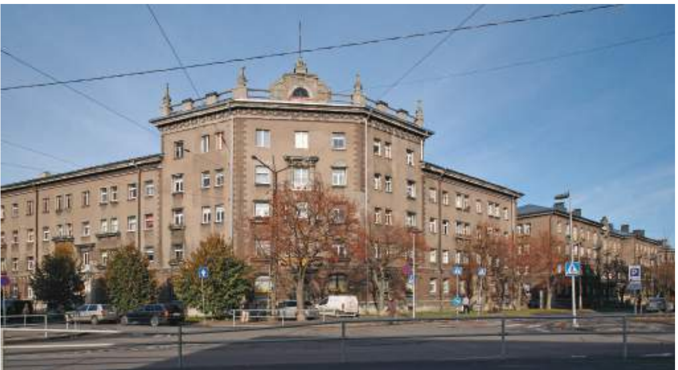
32. Vabriku 2 Kalamajas. Kauplusega elumaja ehitati Volta tehase töötajatele. Arhitekt Lukjanova (Estonprojekt), 1952.
