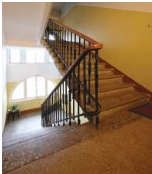
59. Dekoratiivse metallpiirde ja betoonastmetega trepp.
